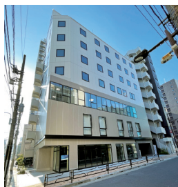
完成した 「ふるさとふれあい館」
